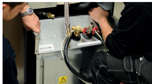
5. Træk kølemodul ud ved først at løfte forkanten lidt op ved hjælp af bærehåndtagene.
